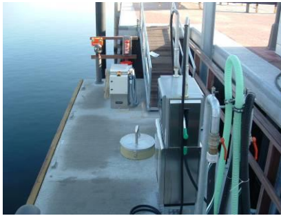
SF1230-8m med septic och gråvattensug, tank, bränslepump för diesel och bensin.
